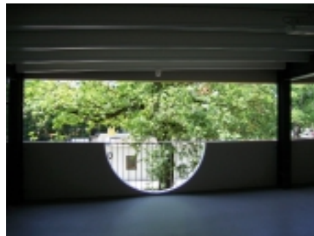
Abb. 18, 19: Fertigstellung Parkhaus von der Fiedlerstraße, Innenaufnahme zur Eiche
